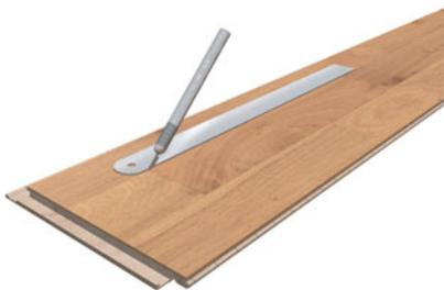
Lackschicht in den Fugen um den betroffenen Stab einschneiden. Lineal verwenden.
